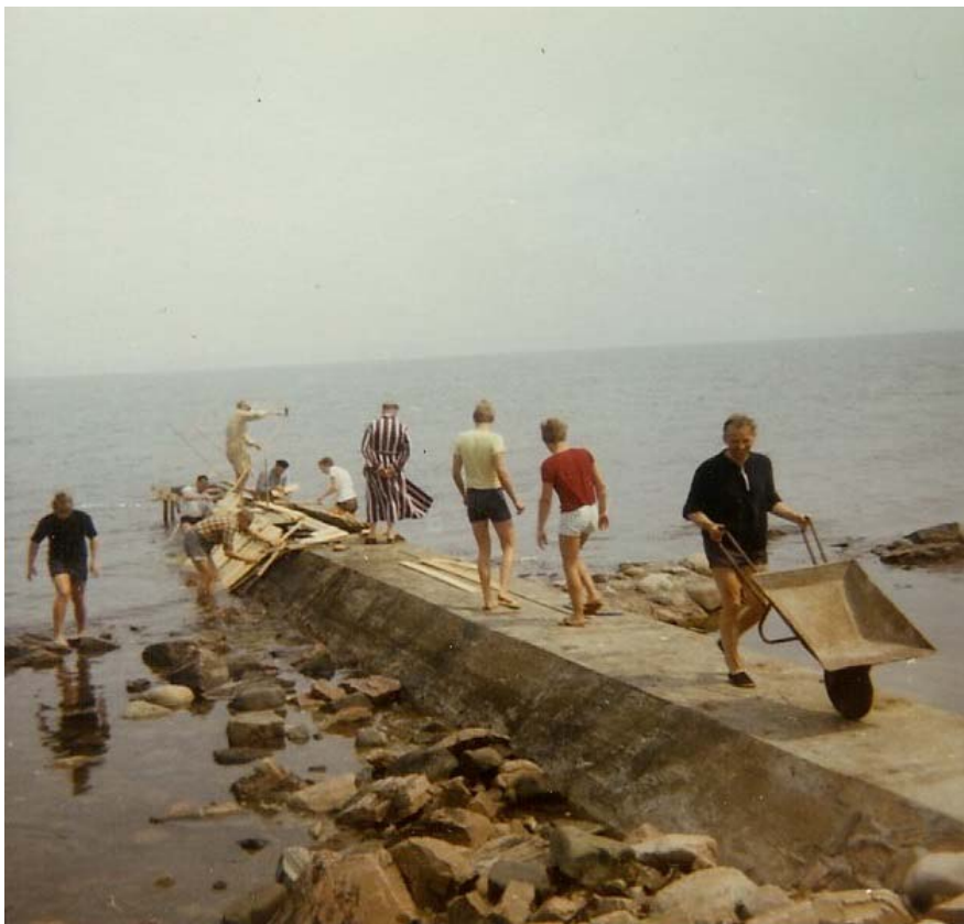
Formsättningen har kommit en bit ut. Några i arbetslaget kan identifieras. Sjunne med skottkärra, Gunnar Augustinsson med händerna på ryggen, strax nedanför Bo Twetman med hammaren. Längre ut pekar Karl Knutsson, Acek verkar stå bekvämt. Bland yngre förmågor står undertecknad i vattnet.
