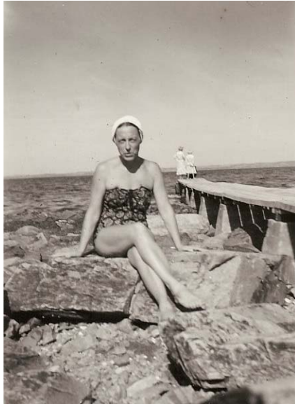
Vid lågvatten kunde de första plintarna ses. Badnymfen är Gisela Twetman
